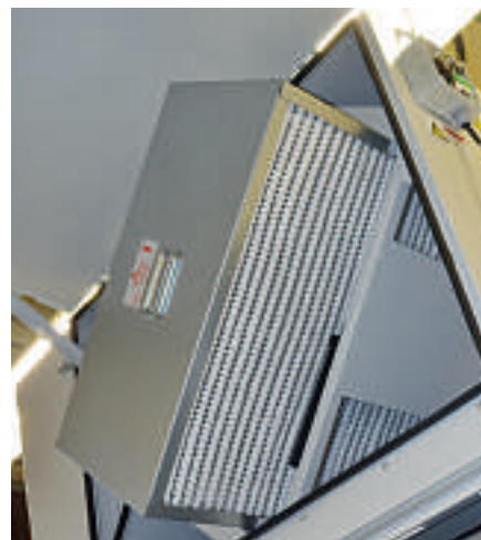
Gut zugänglich: Die Vorfiltereinheit ist als Kasette ausgeführt.
